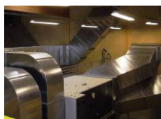
Raccordement de CTA
